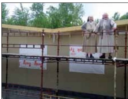
Fornøyde klarisser på byggeplassen.
