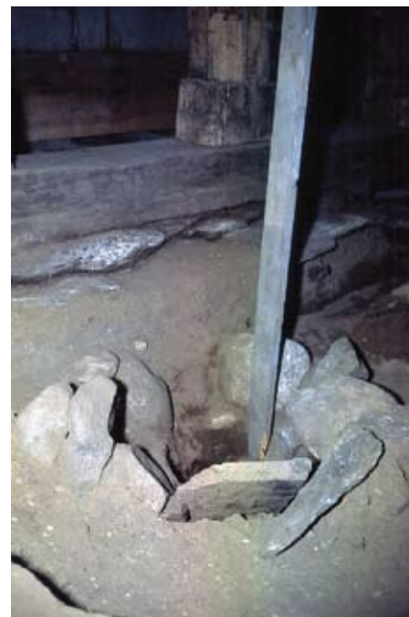
Avdekket stolpehull med stensking. I bakgrunnen grunnstokk med stav. Lom stavkirke. Foto J.H. Jensenius 1973.
