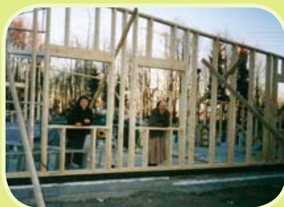
Sr. Walburgis og sr. Elizabeth på byggeplassen, oktober 2003
