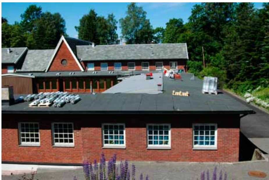
Taket ved begynnelsen av renoveringen.
