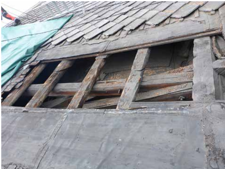
Lektene som takskiferen var spikret i, var i ferd med å råtne bort. Foto: Tromsø stift.
